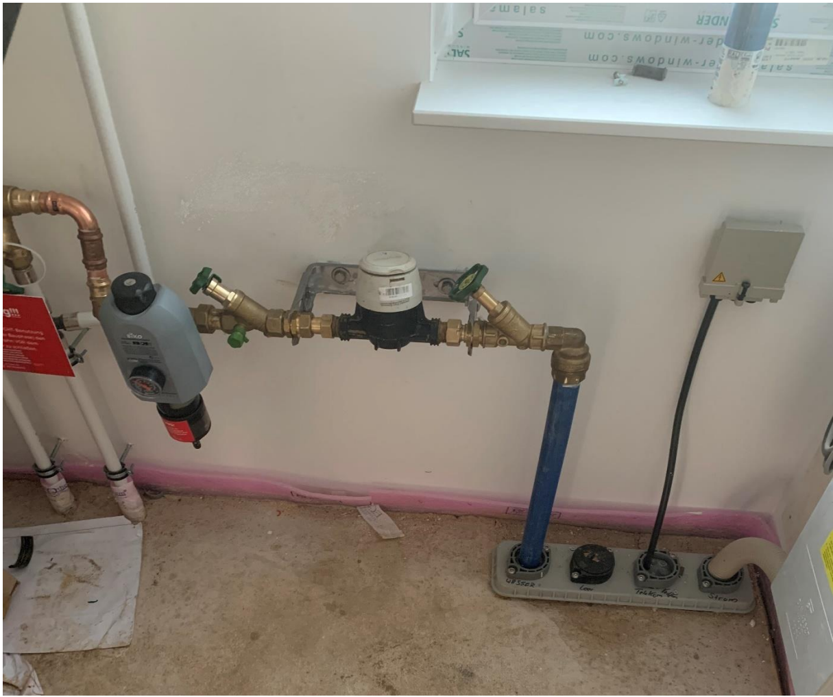
Beispiel MSH Fußbodeneinführung (FUBO)
