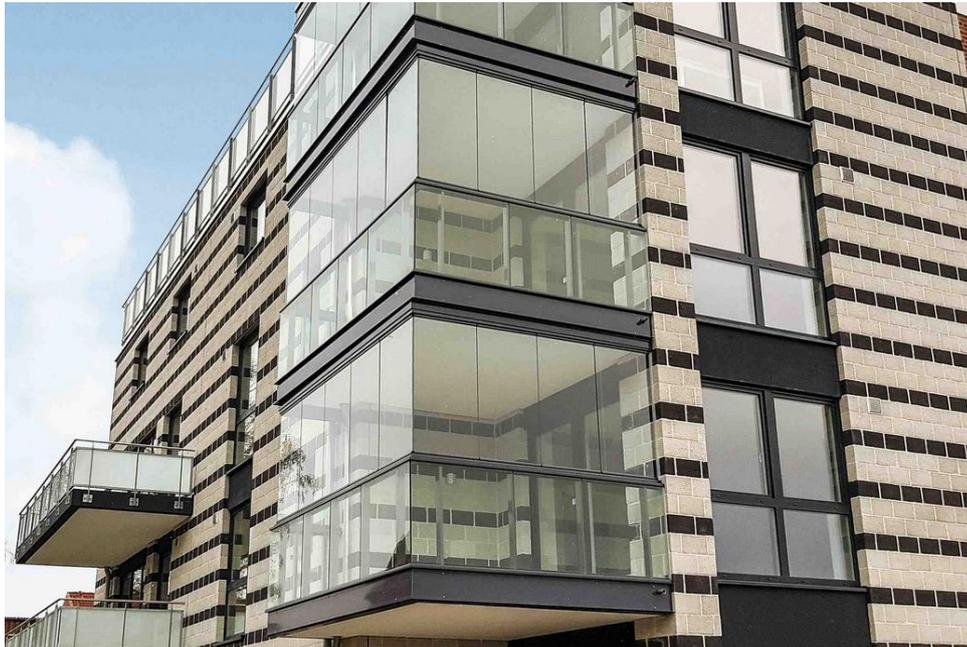
**Abb. 5: Dreh-Schiebe- System Lumon 5 des Herstellers Lumon, Ausführungsbeispiel**
