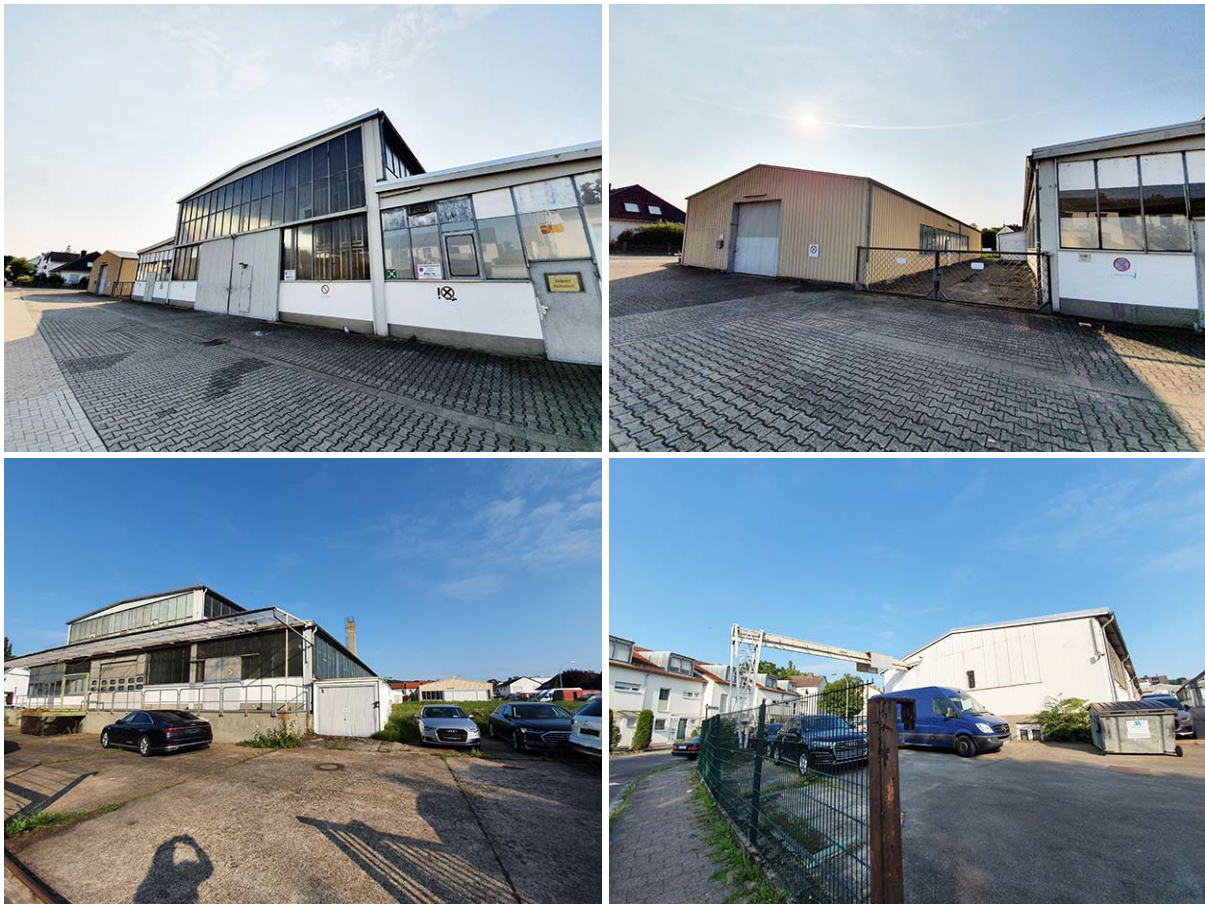
Abbildung 8: Bestehende gewerbliche Hallenstrukturen innerhalb des Plangebietes
